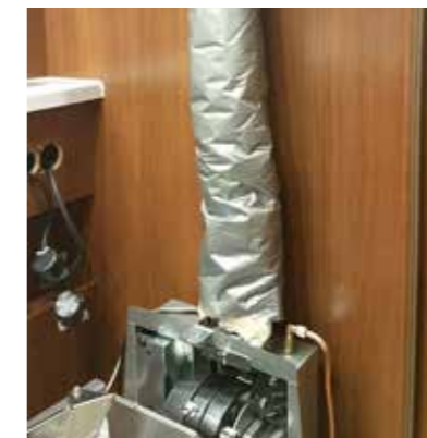
Installation der Toilette und der Abgasventilation
