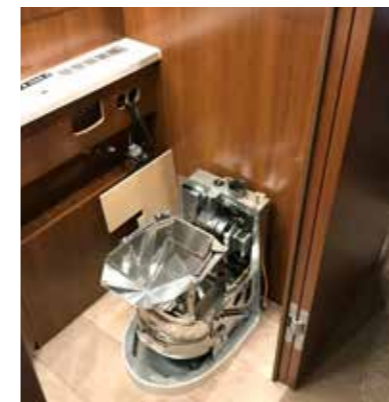
Einpassen und Einbau der Ummantelung des Entlüftungsrohrs
