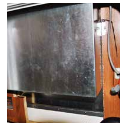
Externe Inspektionsluke für die technische Anlage einbauen
